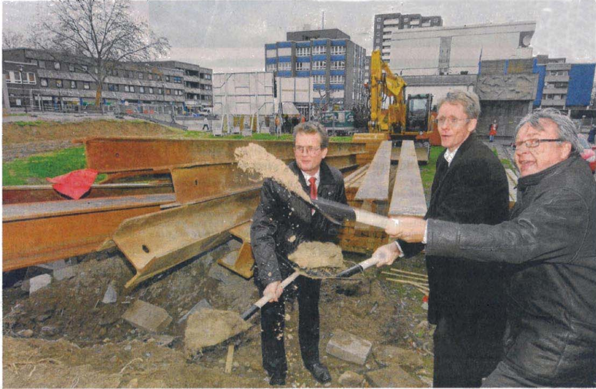
Erster Spatenstich für das Geschäfts- und Pflegehaus am Ernst-Reuter-Platz in Monheim: (v.l.) Bürgermeister Thomas Dünchheim , Architekt Guido Kammerichs und Investor Michael Brandstetter . RP-FOTO: MATZERATH
